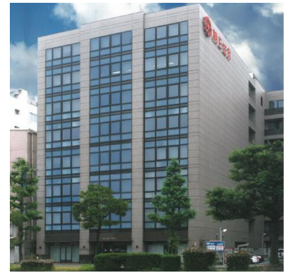
【朝日生命福岡昭和通ビル 外観】
